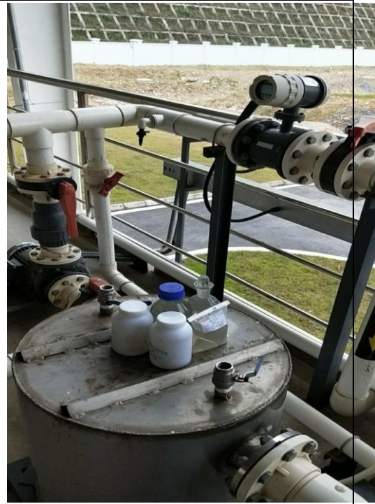
综合池取水口
