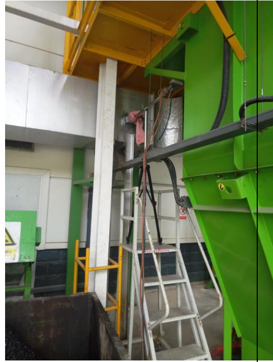
锻造机废气处理前采样口
