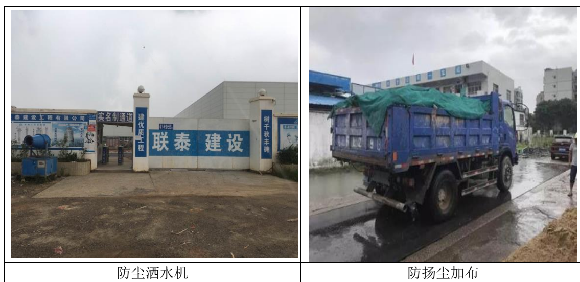
图 4-1 施工期环保措施现场图
